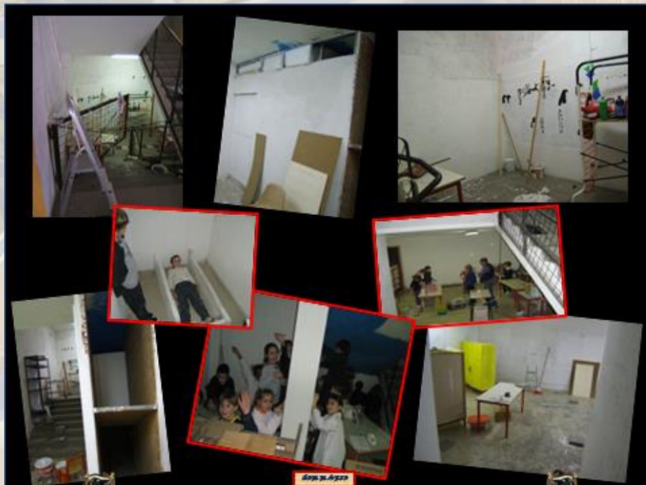
Realizzazione di strutture...
